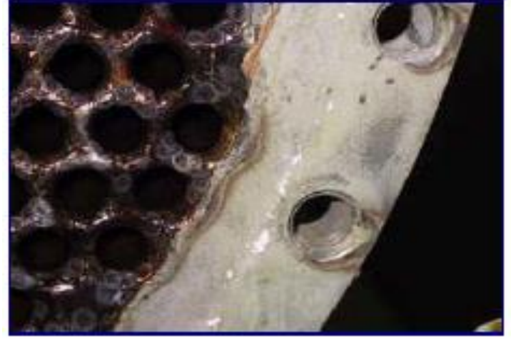
25Cr superduplex heat exchangerda deniz suyu ile soğutulmasının ardından geçen iki yıl sonrasındaki biofilm ve korozyon oluşumu
