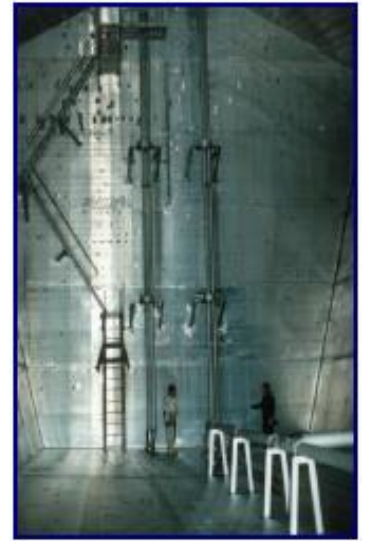
Paslanmaz çelik yükleme tankının picklingi
