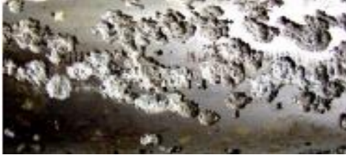
AISI 316 borusunda oluşan çukur şeklindeki aşınma
